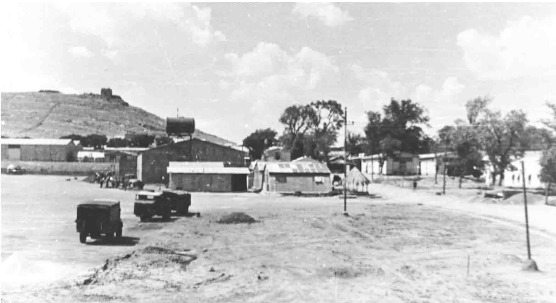
EALA 6/72 – Les installations à Khenchela en 1958
