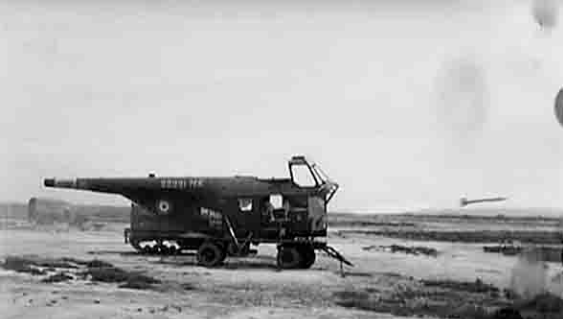
Essais au sol de roquettes T-10 et de panier Matra avec une carcasse de H-19
